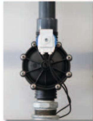
**Elektrische Steuerung über 24V Magnetventile**
